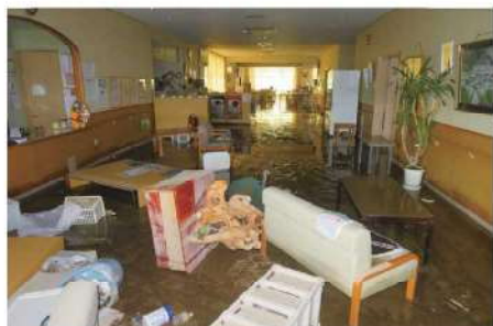
②りんこの郷 水が引いた後の施設内
