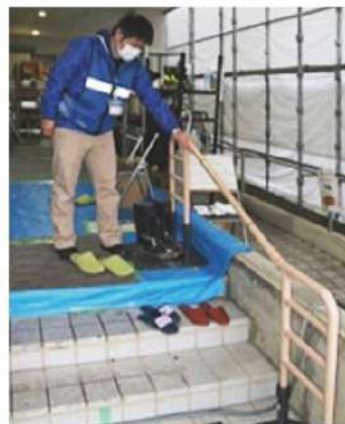
階段の手すり設置
