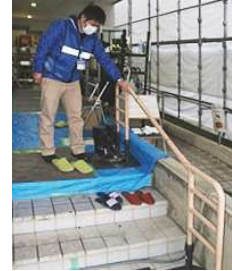
階段の手すり設置
