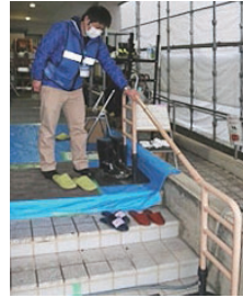
階段の手すり設置
