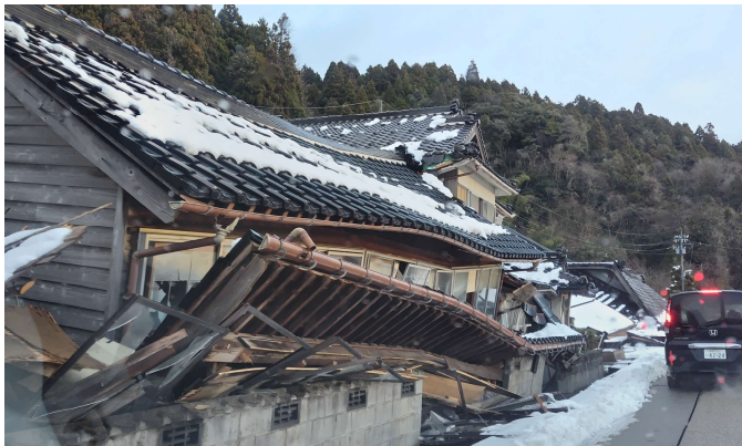
能登町の入口付近、倒壊家屋
