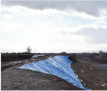
▲決壊現場付近は2重の堤防を築く工事が進行中
