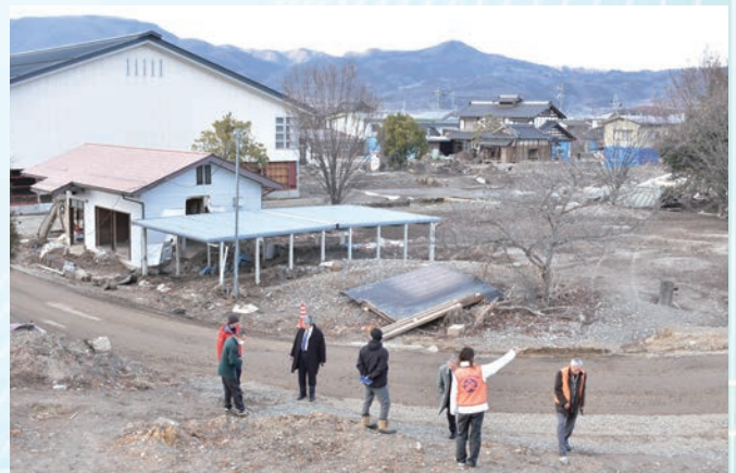
▲決壊現場津野地区の堤防から見下ろした視察の様子
