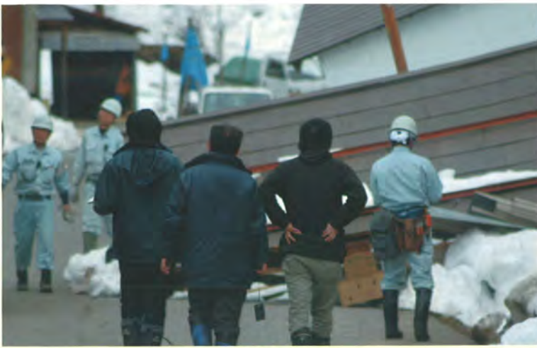
震災直後の倒壊現場 ※
