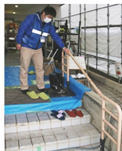
階段の手すり設置
