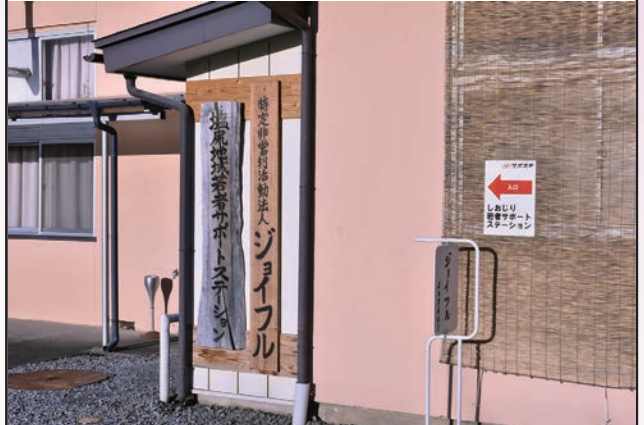
▲保育園を改装した建物で、閑静な住宅街にあります
