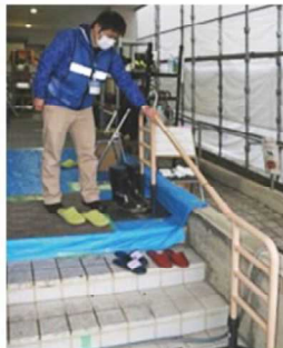
階段の手すり設置
