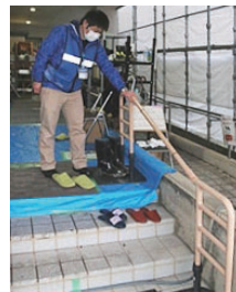
階段の手すり設置
